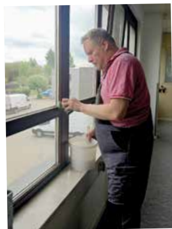
Nach dem Streichen wurde auch alles gründlich geputzt.
